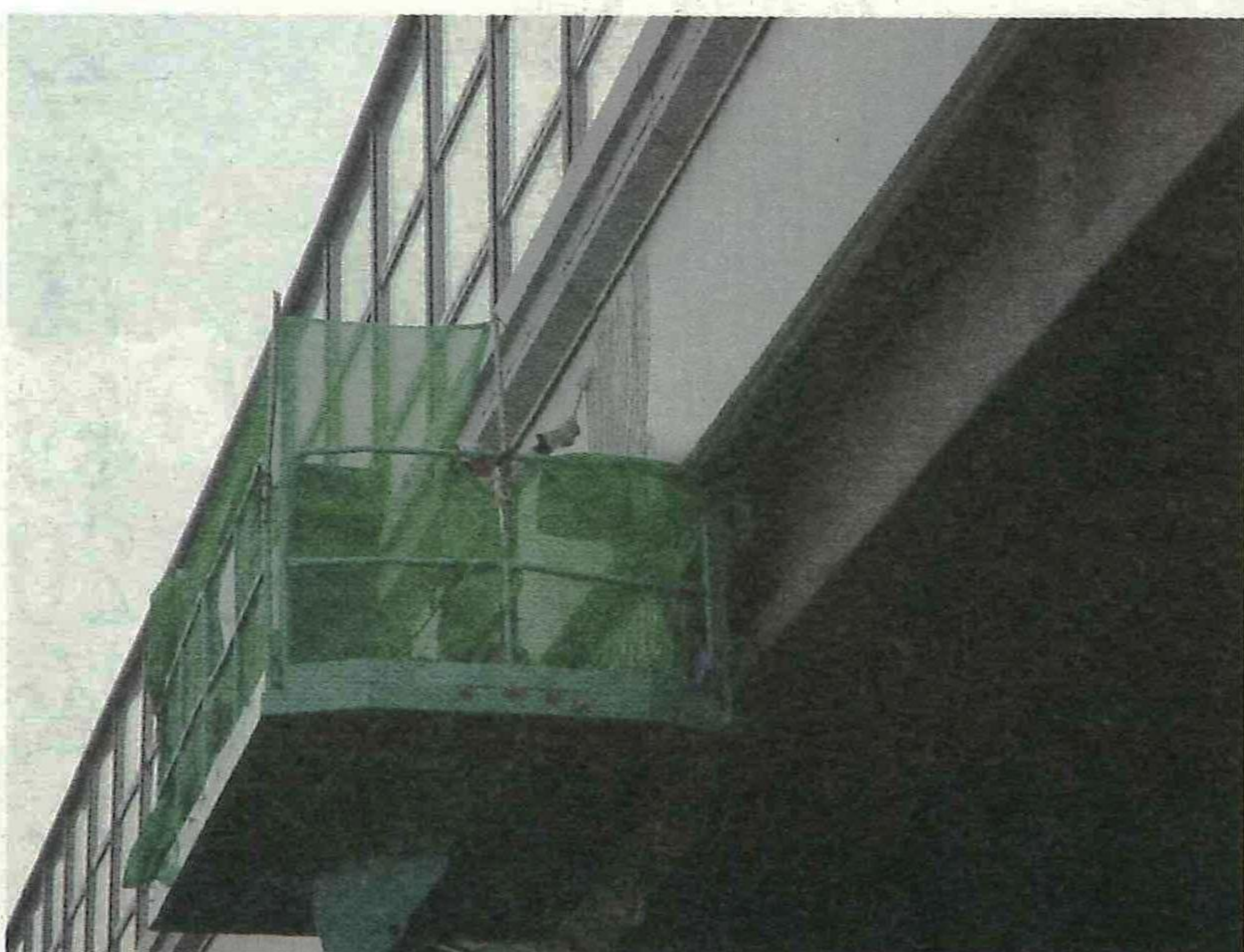
剥落防止材塗布 (上重原高架橋)
